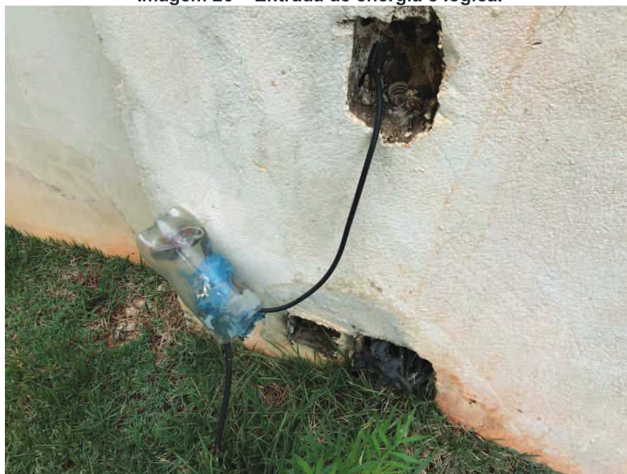
Imagem 26 – Entrada de energia e lógica.
