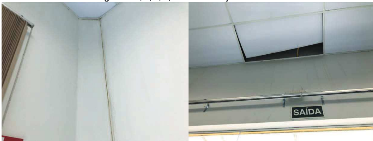
Imagem 13 a, b, c, d, e e f – Infiltrações do telhado.
