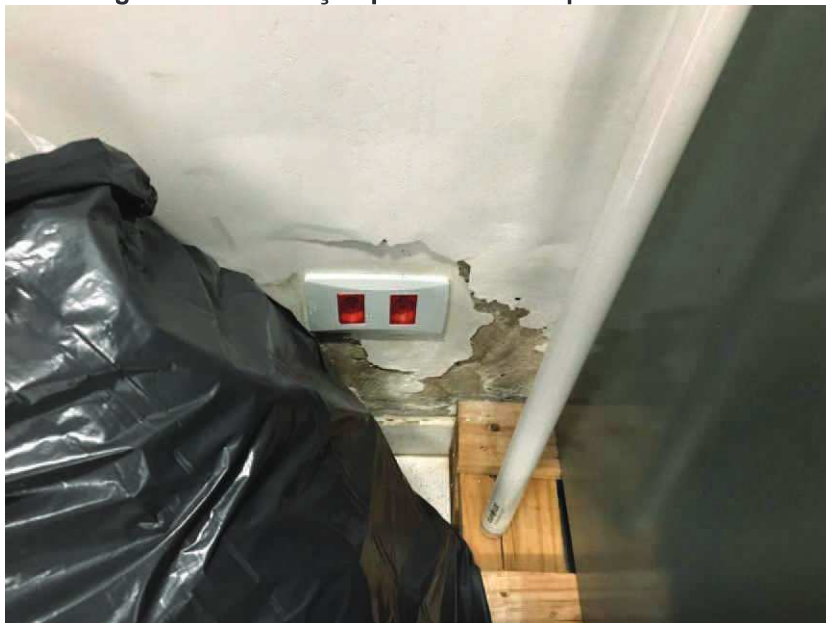
Imagem 15 – infiltração pelo solo no depósito de urnas.
