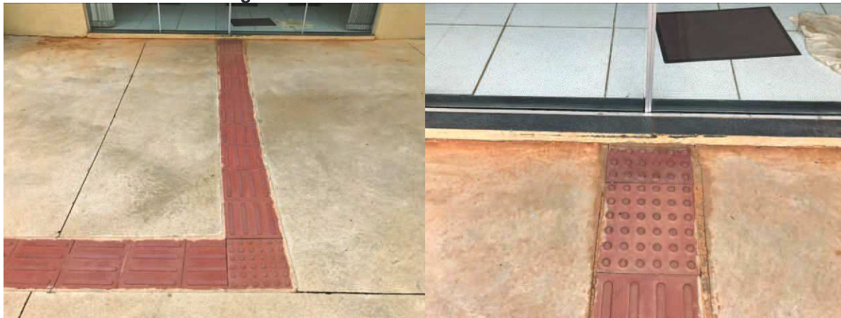
Imagem 4 a e b – Piso tátil e desnível de entrada.
