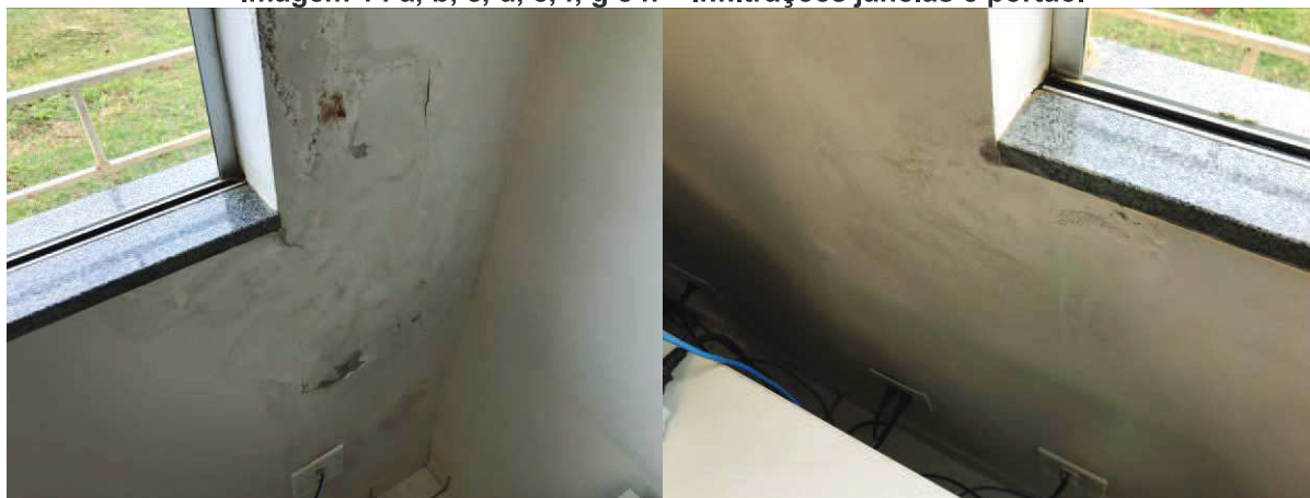
Imagem 14 a, b, c, d, e, f, g e h – Infiltrações janelas e portão.
