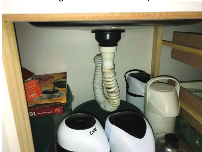
Imagem 19 – Vazamento na pia.
